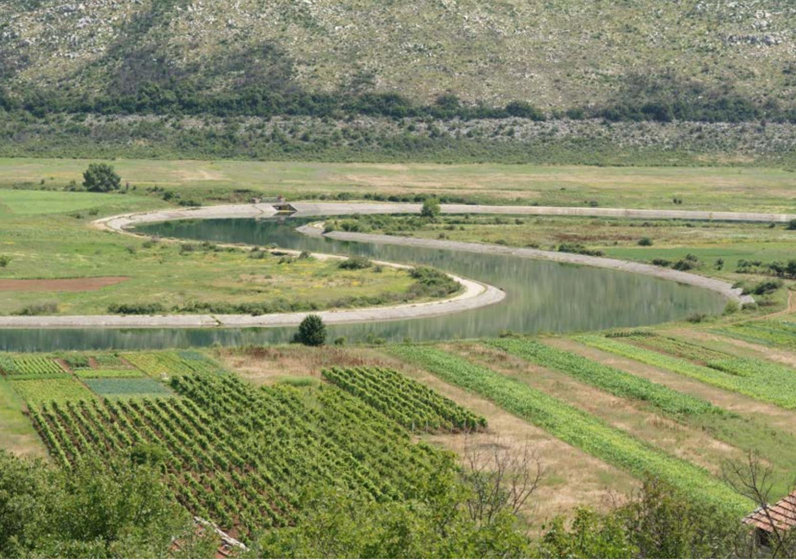
Fotografija 5. Popovo polje s dijelom Trebišnjice obloženim špricanim betonom
