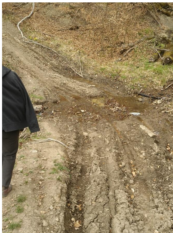
Ф.16. Під'їзна дорога через потік
