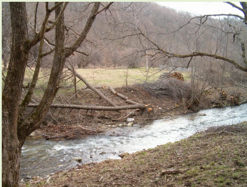
Прочистване на речните корита – река Станчевханска
