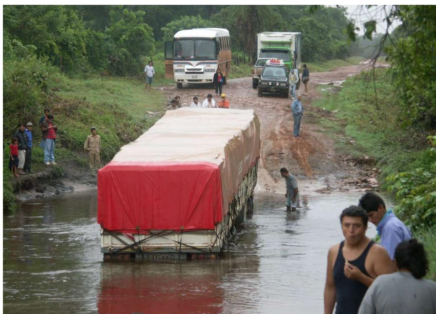
Figura 27: El terraplén de la actual carretera no asfaltada que cubre el trayecto entre Santa Cruz y Puerto Suárez, muestra secciones de poca estabilidad como lo evidencia este hundimiento del terreno, ocurrida el 16 de enero de 2005.
