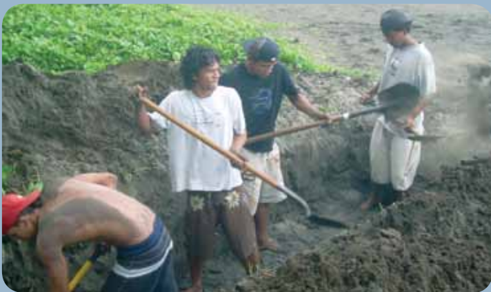
Los Baula Boys del CBP comienzan a excavar la primera trinchera para enterrar las pipas.
