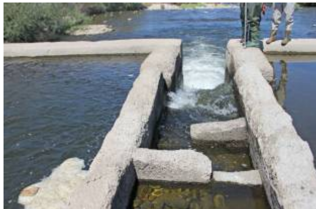
Фигура 5. Рибен проход на р. Искър с конструкция и хидравлични параметри, които не позволяват навлизането на риби през входа. Ляво: вход на рибен проход несъответстващ на възможностите на рибите по отношение на наклон, скорост на водата, ниво на турбулентия. Дясно: същото съоръжение откъм изхода, който рибите, мигриращи срещу течението, не биха могли да достигнат.
