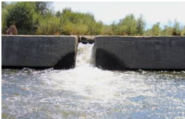
Фигура 5. Рибен проход на р. Искър с конструкция и хидравлични параметри, които не позволяват навлизането на риби през входа. Ляво: вход на рибен проход несъответстващ на възможностите на рибите по отношение на наклон, скорост на водата, ниво на турбулентия. Дясно: същото съоръжение откъм изхода, който рибите, мигриращи срещу течението, не биха могли да достигнат.
