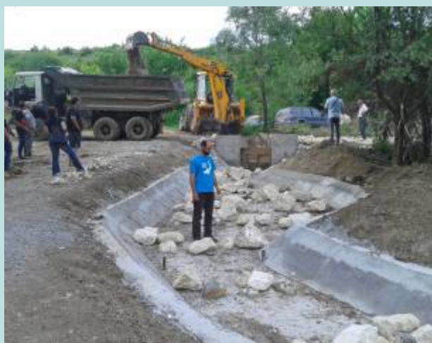
Етапи в строителството и зазиряването на байпасен канал на р. Русенски Лом
