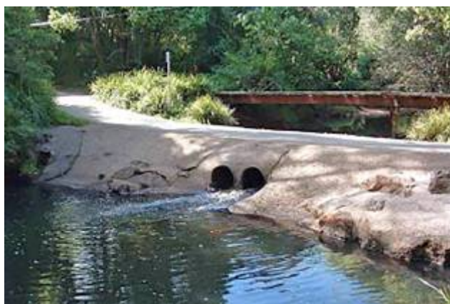
Фигура 30. Позициониране на водостоци в пътни съоръжения. Ляво: правилно позициониране. Дясно: недостъпно съоръжение за рибите през периода на маловодие (р. Дива)
