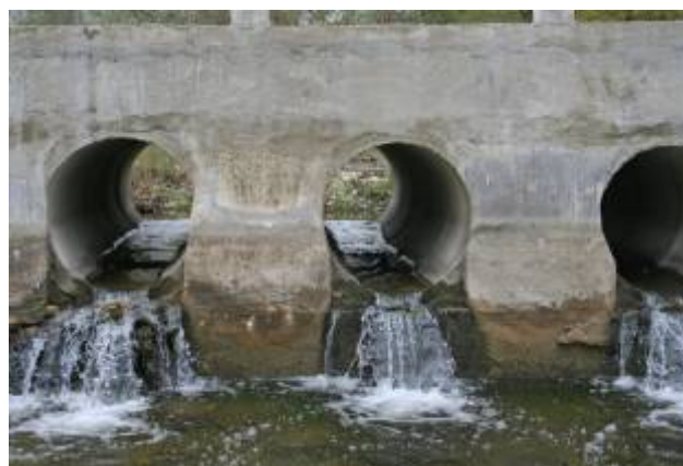
Фигура 30. Позициониране на водостоци в пътни съоръжения. Ляво: правилно позициониране. Дясно: недостъпно съоръжение за рибите през периода на маловодие (р. Дива)
