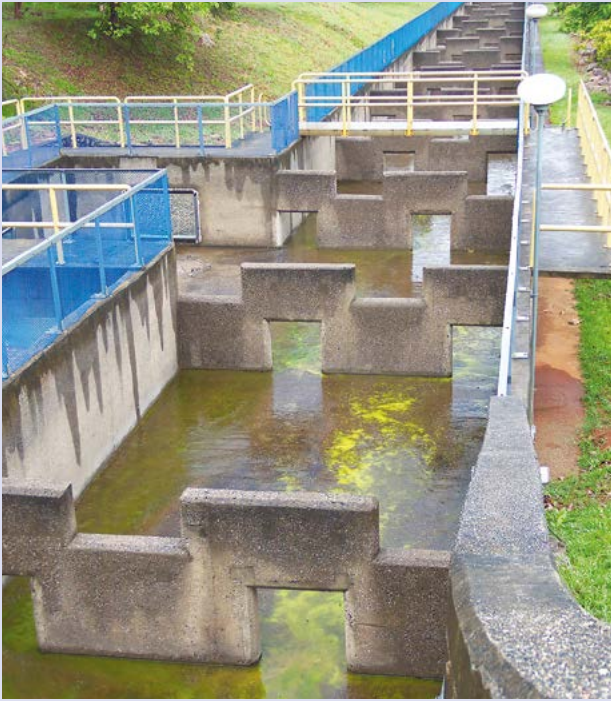
Escala de peces en la presa de Lajeado se cerró. Los estudios han demostrado que este tipo de acciones de mitigación no ha logrado mantener la migración de los peces.
