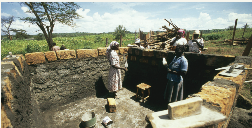
Mulheres africanas misturam argamassa para a construção de uma cisterna no Lago Nakuru, Quênia
