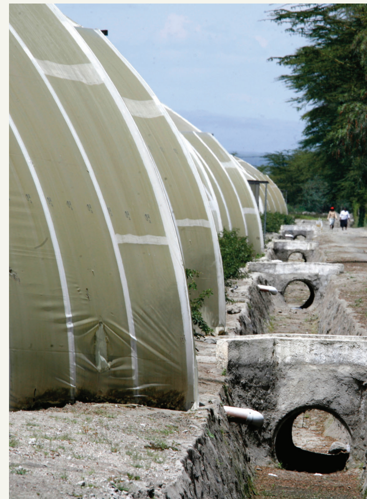
Água de irrigação de estufas recolhida em canais de escoamento, região do Lago Naivasha, Quénia.
