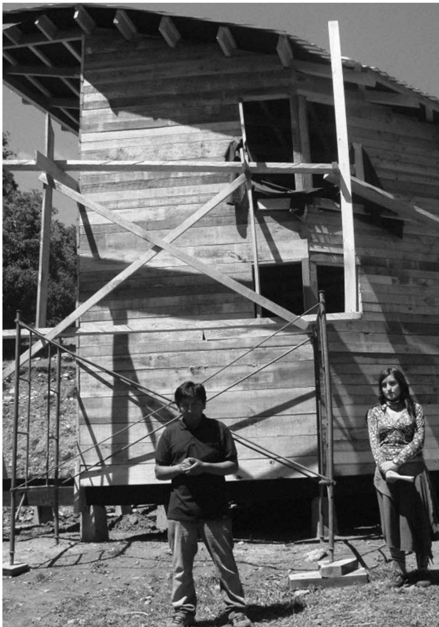
Construcción de ruka ecolodge en Mapu Lahual. © WWF Chile.
