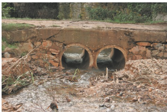
Фигура 30. Позициониране на водостоци в пътни съоръжения. Ляво: правилно позициониране (приток на р. Панагюрска Луда Яна). Дясно: недостъпно съоръжение за рибите през периода на маловодие (р. Дива)
