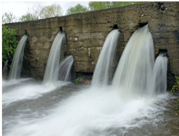
Фигура 3. Речни води, преминаващи през водостоци. Дясно горе: позиционирани твърде високо над речното ниво (приток на р. Какач). Ляво долу: недостъпни за рибите при ниско ниво на водата (р. Дива / р. Читак дере); Дясно долу: целогодишно недостъпни (р. Палакария).
