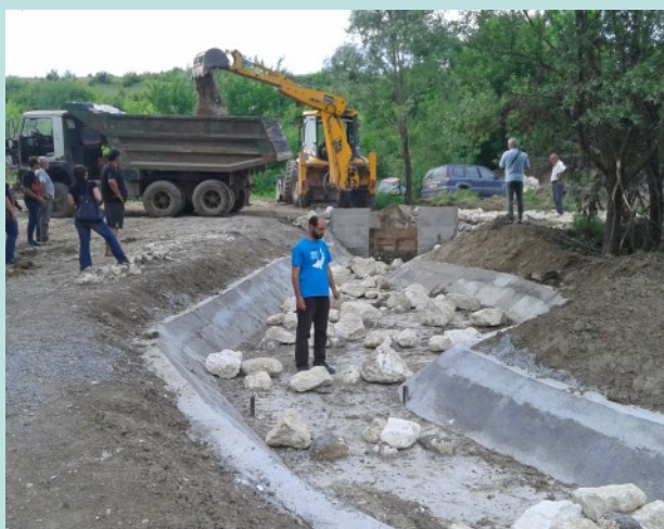
Етапи в строителството и завиряването на байпасен канал на р. Русенски Лом
