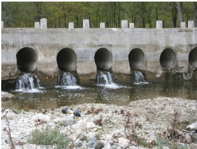
Фигура 3. Речни води, преминаващи през водостоци. Дясно горе: позиционирани твърде високо над речното ниво (приток на р. Какач). Ляво долу: недостъпни за рибите при ниско ниво на водата (р. Дива / р. Читак дере); Дясно долу: целогодишно недостъпни (р. Палакария).
