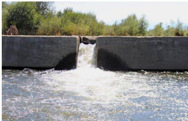
Фигура 5. Рибен проход на р. Искър с конструкция и хидравлични параметри, които не позволяват навлизането на риби през входа. Ляво: вход на рибен проход, несъответстващ на възможностите на рибите по отношение на наклон, скорост на водата, ниво на турбулентция. Дясно: същото съоръжение откъм изхода, който рибите, мигриращи срещу течението, не биха могли да достигнат.
