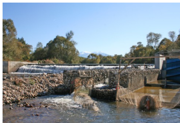
Фигура 31. Мрежени капани на входа на рибен проход с цел установяване миграция на риби (р. Искър, Проект NYLOW, 2011)
