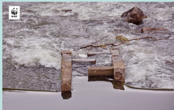
Прагът на р. Вит при с. Торос и съоръжението рибен проход в централната му част
