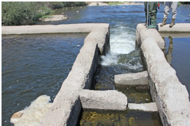
Фигура 5. Рибен проход на р. Искър с конструкция и хидравлични параметри, които не позволяват навлизането на риби през входа. Ляво: вход на рибен проход, несъответстващ на възможностите на рибите по отношение на наклон, скорост на водата, ниво на турбулентция. Дясно: същото съоръжение откъм изхода, който рибите, мигриращи срещу течението, не биха могли да достигнат.
