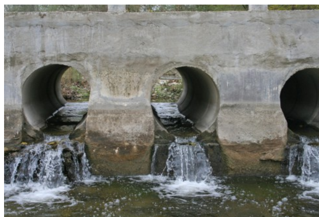
Фигура 30. Позициониране на водостоци в пътни съоръжения. Ляво: правилно позициониране (приток на р. Панагюрска Луда Яна). Дясно: недостъпно съоръжение за рибите през периода на маловодие (р. Дива)
