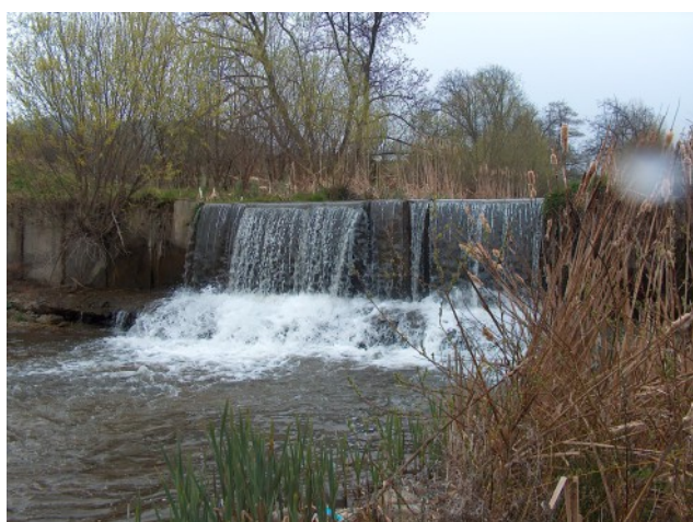
Фигура 2. Прагове с различно предназначение в речните корита, които могат да са и твърде различни по своята височина, ширина и хидравлични характеристики.
